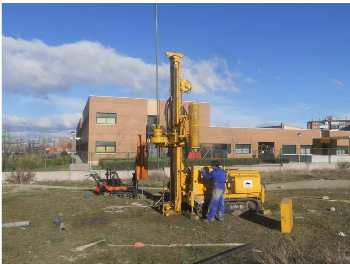
FOTOGRAFIA 3: Vista de la perforación del segundo sondeo y penetrómetro: B
